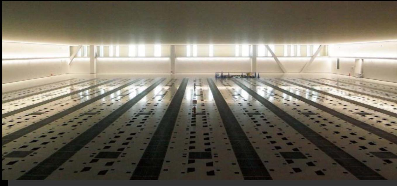
2Fの空調機2台のみを稼動し、計算機室の空気の流れを計測した結果とシミュレーション結果を比較
